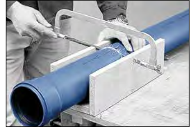
İnce dişli testere ile boy kesme (ŞEKİL 17)
